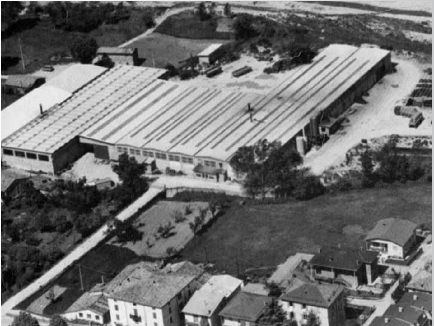
Stabilimento di Calestano anni '60 / Factory of Calestano '60
