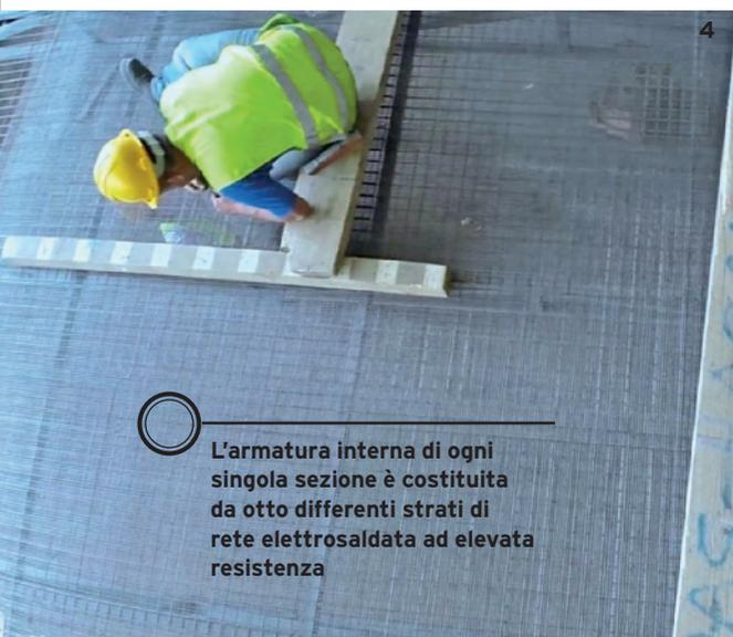
L'armatura interna di ogni singola sezione è costituita da otto differenti strati di rete elettrosaldada ad elevata resistenza
