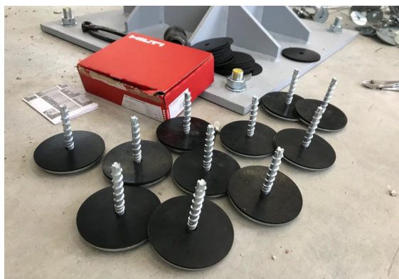
Figura 1.3 – Rondelle tipo A e B accoppiate con tasselli.
