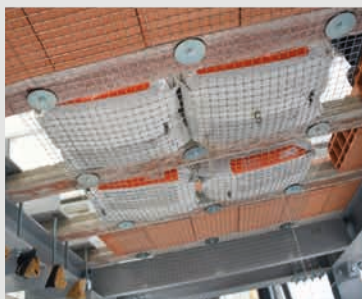
Test con carico uniformemente distribuito applicato con sacchi di sabbia
